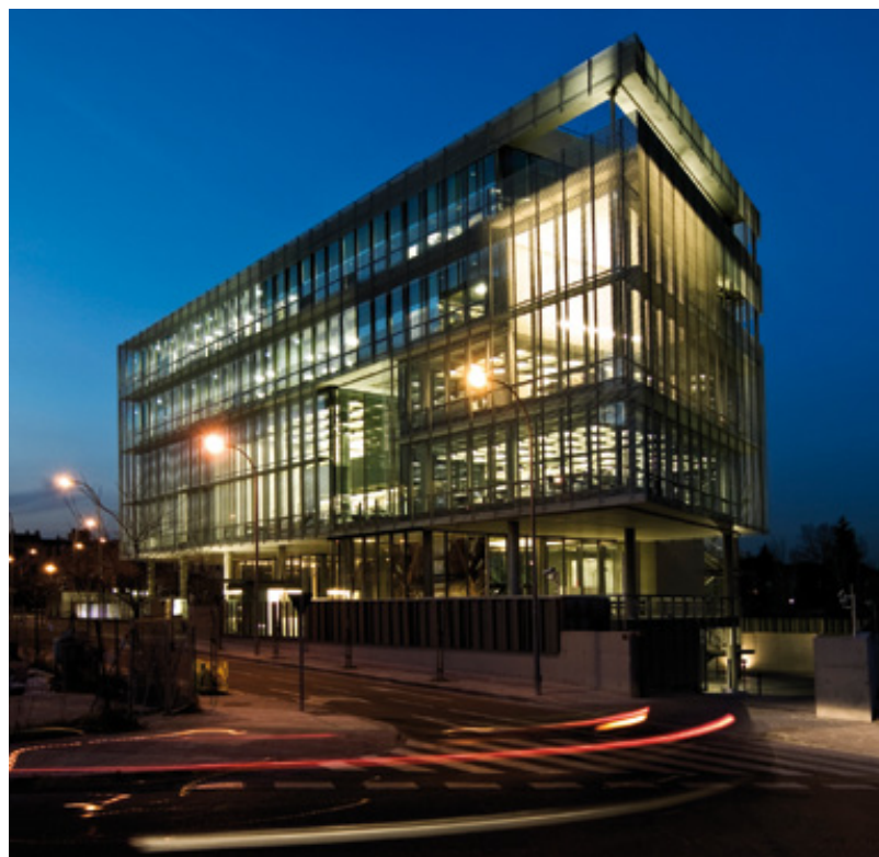
Edificio Sede Estudio Lamela en Madrid, (2008).
